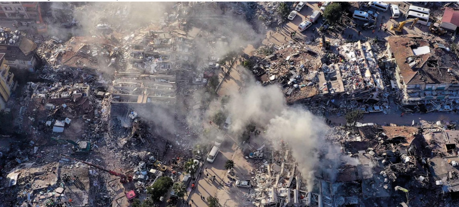
Abb. 36: Gebäude von der Vogelperspektive in Antakya (Malla 2023).
