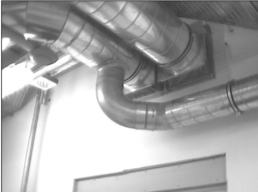
Abbildung 47: Stahlblechlüftungskanal
