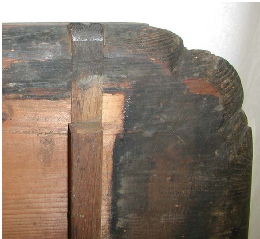
Abb. 124 Unterseite einer Tischplatte mit eichener Gratleiste im Nadelholzträger, Braunschweigisches Landesmuseum
