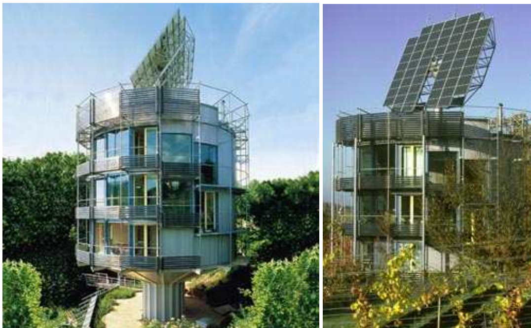
Fig. 5.4: The Heliotrope in Freiburg: Example of Solar Tracking BIPV (arch. Rolf Disch)
