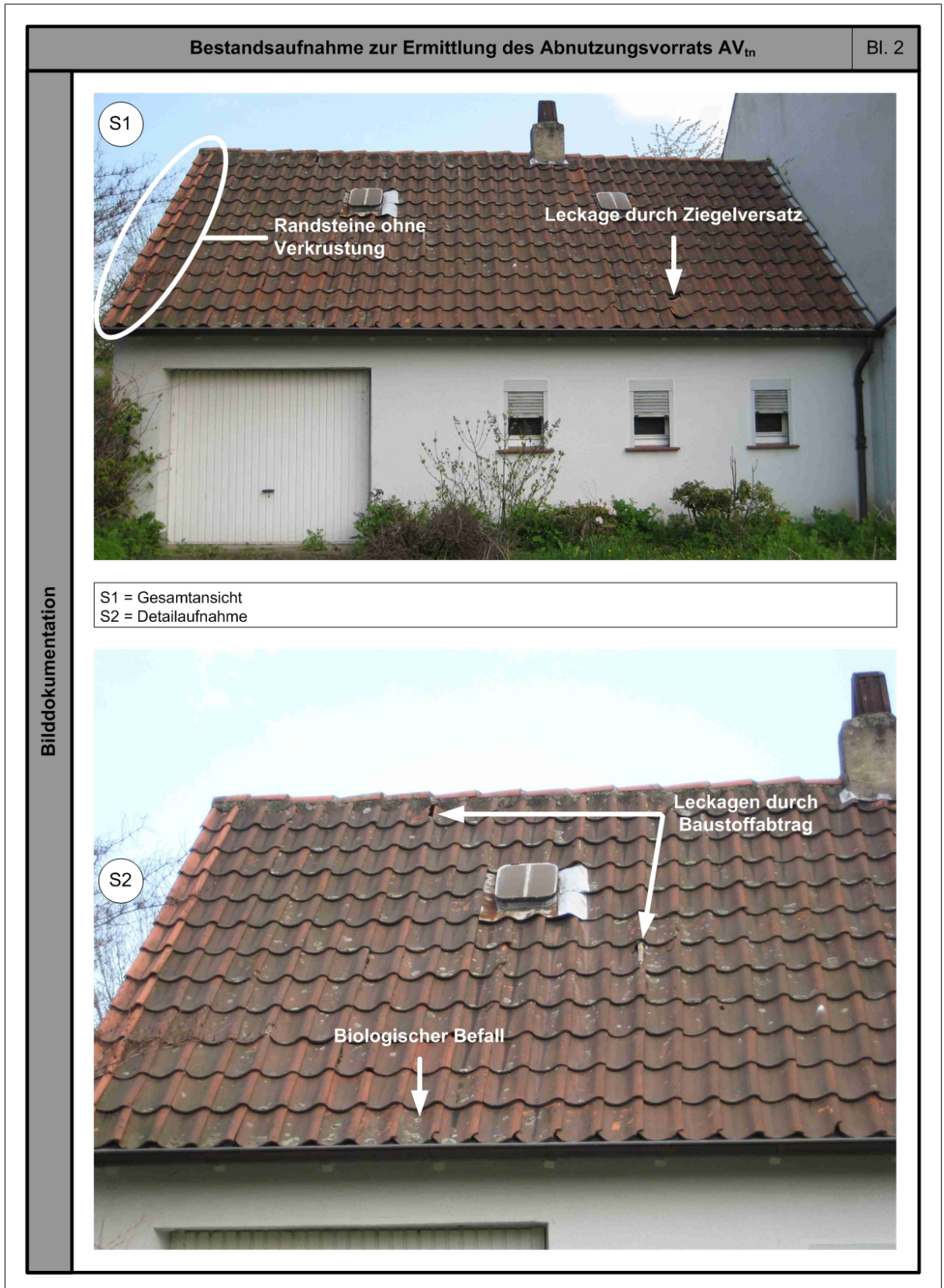
Abb. 358: Bestandsaufnahme zur Ermittlung des Abnutzungsvorrats – Ziegel, statisch nicht relevante Bauelemente – Bl. 2
