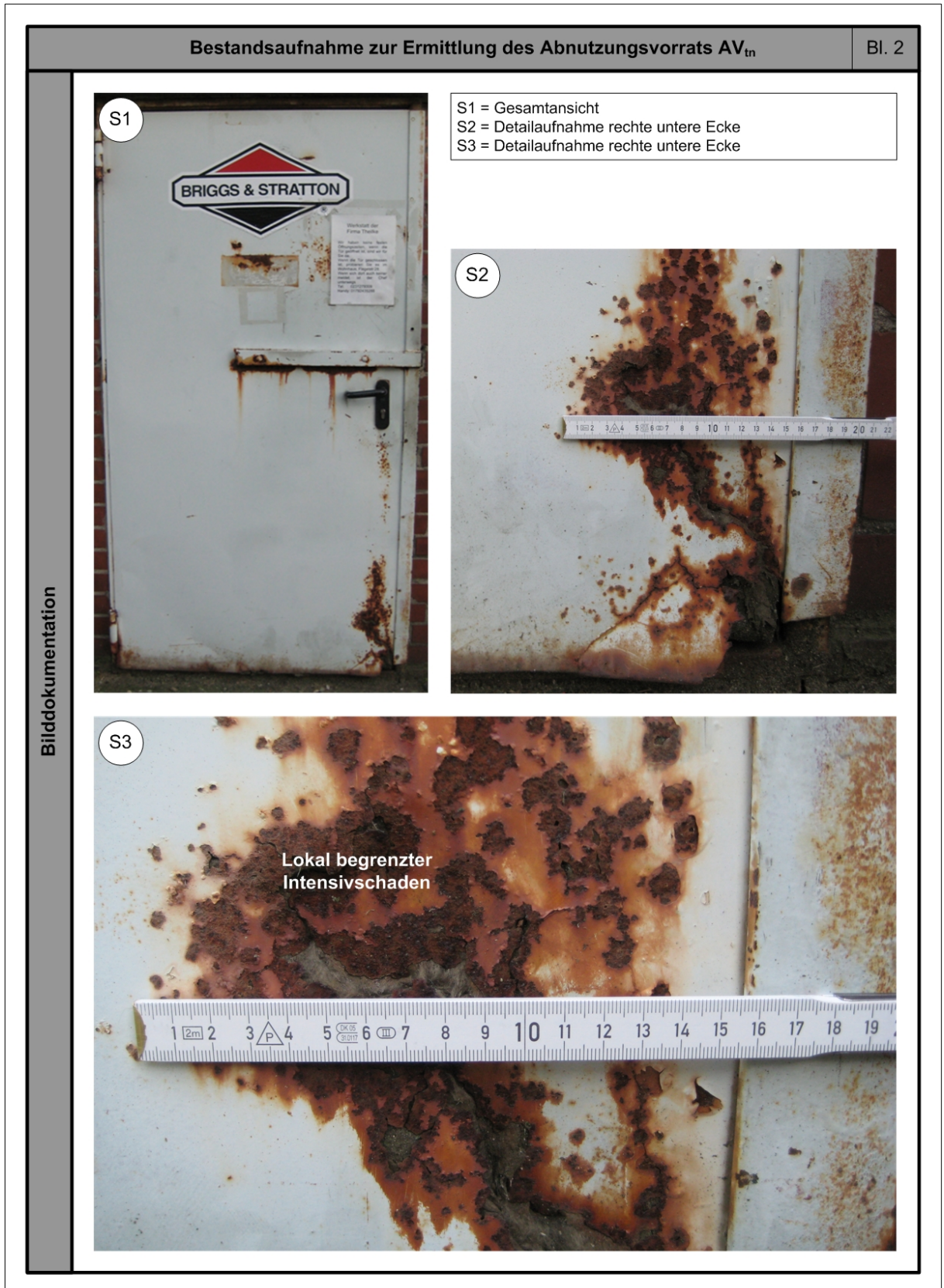
Abb. 320: Bestandsaufnahme zur Ermittlung des Abnutzungsvorrats – Stahl (unlegiert), statisch nicht relevante Bauelemente – Bl. 2
