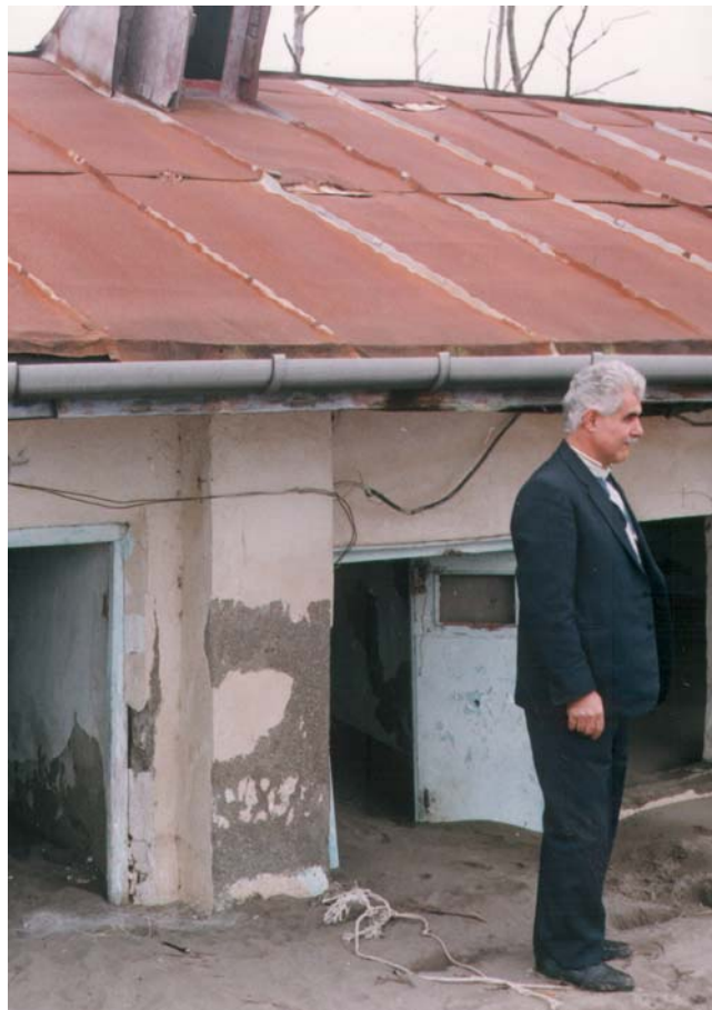
Abb. 4-1: Zerstörte Schule im Bereich der Küstenlinie – bereits zur Hälfte im Sand eingegraben. Erkennbar wird damit zum einen der Rückzug der Küste, allerdings verlangsamt durch die Sandanschüttung, die hier ein halbes Stockwerk beträgt.
