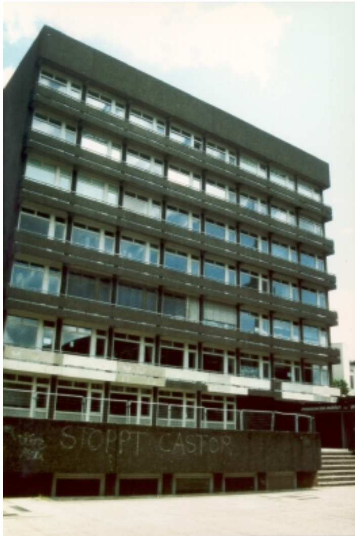
Abb. 22: Bauwerk mit Waschbetonoberfläche (Probeflächen im 1. OG bereits angelegt)
