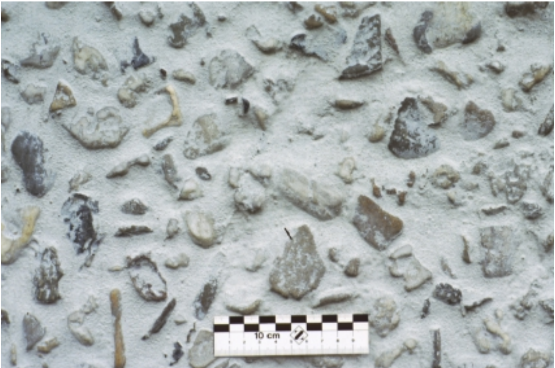
Abb. 13: Zementschleier auf den Zuschlägen nach dem Auswaschen
