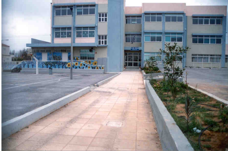
Neubau einer Grundschule in Maroussi, einem Vorort von Athen; Fertigstellung 1999. (Eigene Aufnahme)
