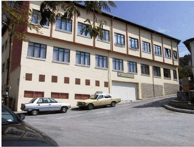
Typisches EIN- Gebäude
