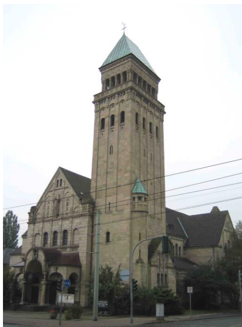
Abb. 5.4 – Ansicht von Nordosten [2006]
