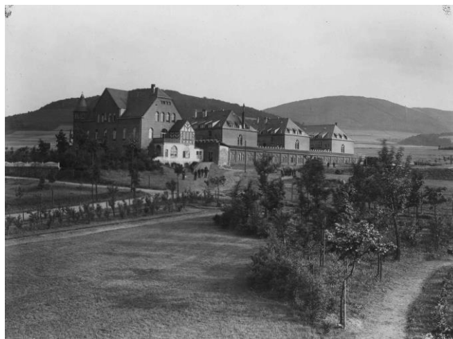
Abb. 1.1 – Josefsheim mit Baugrube der Kapelle [AJB]
