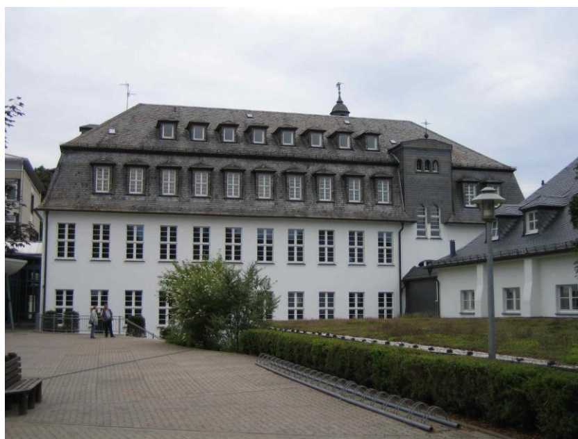
Abb. 2.2 – Erweiterungsbau vom Schulhof aus
