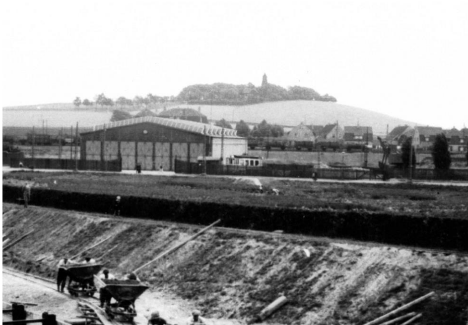
Abb. 2 – Wagenhalle zur Zeit der Bauarbeiten des Emscherkanals, 20.06.1939 (Ausschnittvergrößerung) [SttA-Rott]
