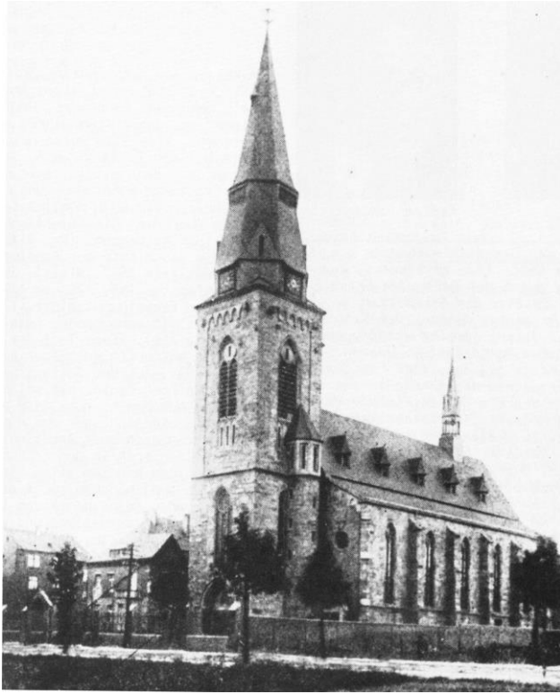
Abb. 9 – Nordwestansicht, Fotografie, undat. [Festschrift 1986, S. 27.]
