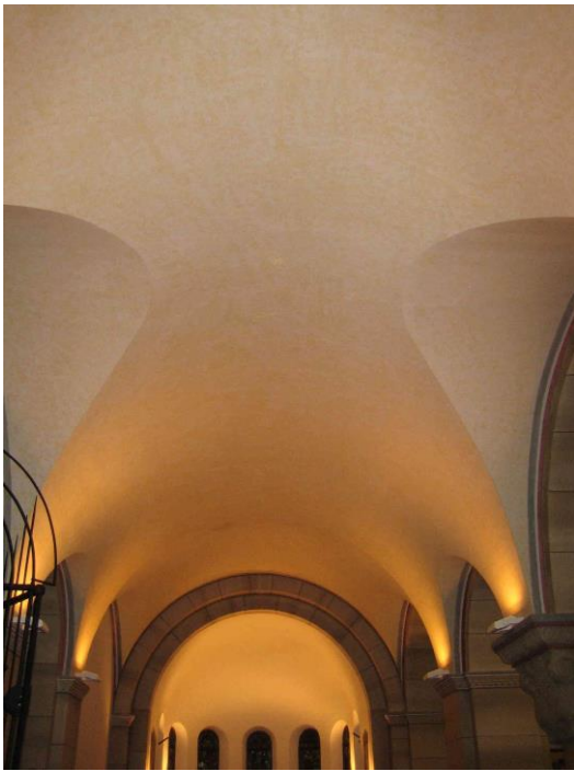
Abb. 7 – Tonnengewölbe in Richtung Taufkapelle [2007]
