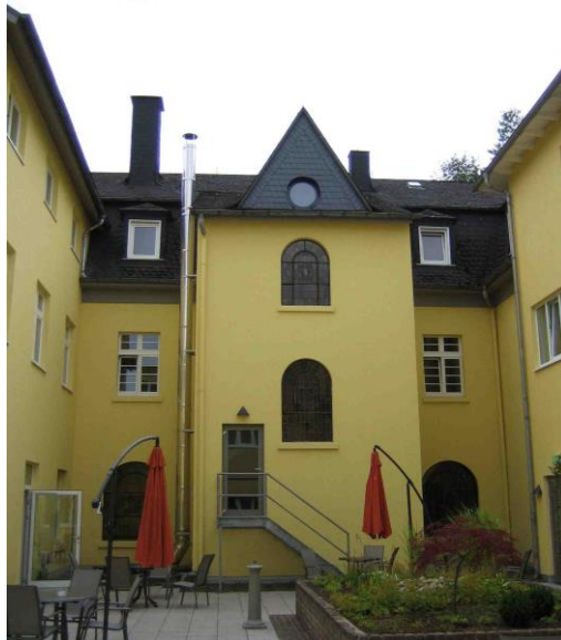
Abb. 11 – Rückansicht nach Umbau [2006]
