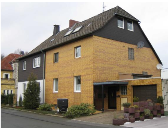
Abb. 6.1 – Limburger Postweg 36/38 mit 1978 aus- gebautem Dach [2006]
