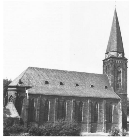
Abb. 10 – Ansicht mit neuem Kirchendach, 1964 [Festschrift 1986, S. 54.]
