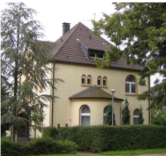
Abb. 3 – Pfarrhaus von Südwesten
