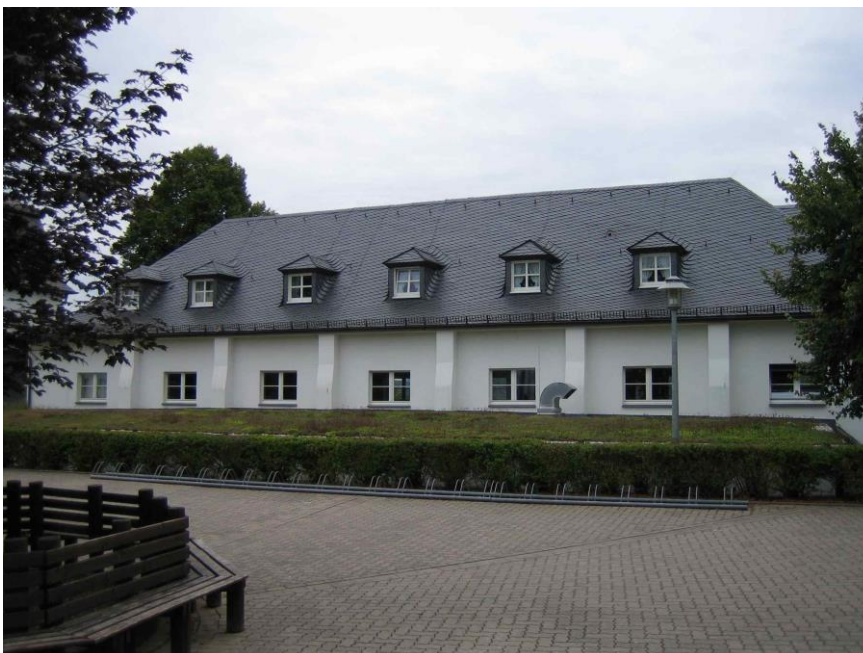
Abb. 4 – Turnhalle/Aula vom Schulhof aus
