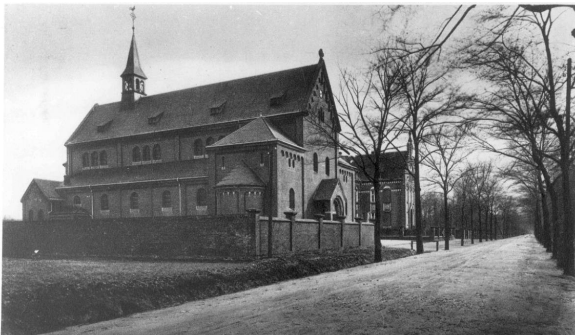
Abb. 5 – Klosterkirche an der alten Straße [Hensel/Hünting/Jörgens-Kemna, S. 34. – LWL-WAfD 84-1487-15. – UDB-RE]
