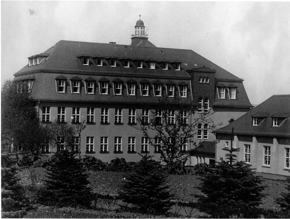
Abb. 1.2 – Erweiterungsbau des Ursulinenklosters mit Turnhalle, 1936
