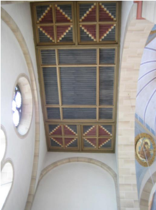
Abb. 20 – Holzdecke im nördlichen Querhaus [2007]
