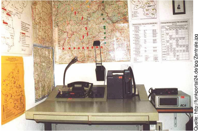
Abbildung 2.1: Fernmeldezentrale: Führungstelle mit Sprechfunk- und Fernsprechbetrieb
