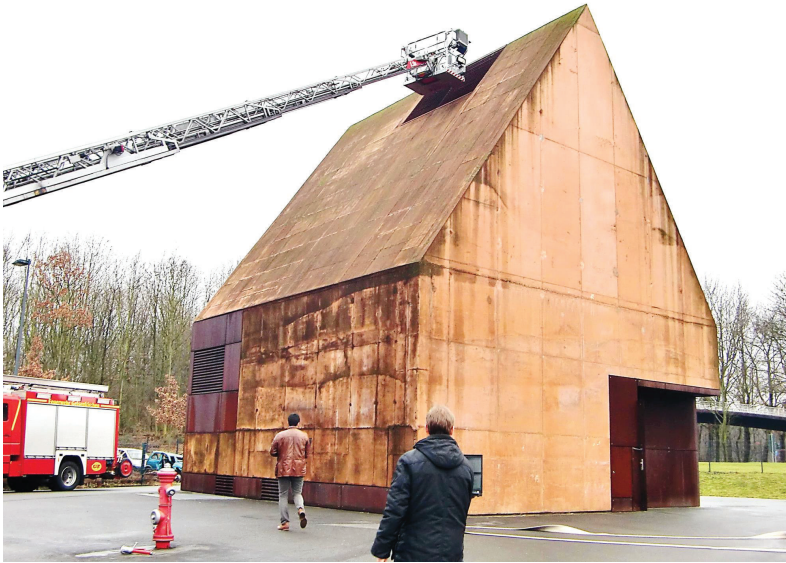
Abbildung 6.8: Brandhaus der Feuerwehr Gelsenkirchen
