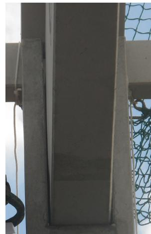
**Bild 7.15:** Geometrische Imperfektionen: a) Herstellungsbedingte Auslenkung b) Schiefstellung am Auflager
