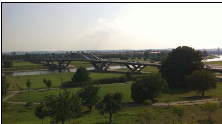
Abbildung 21: Die Dresdner Waldschlösschenbrücke im Sommer 2015
