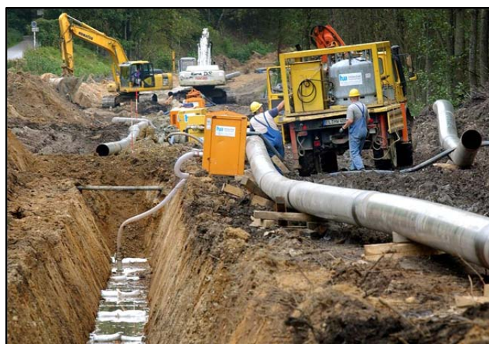
Abbildung 32: Der Bau der CO-Pipeline im Sommer 2007
