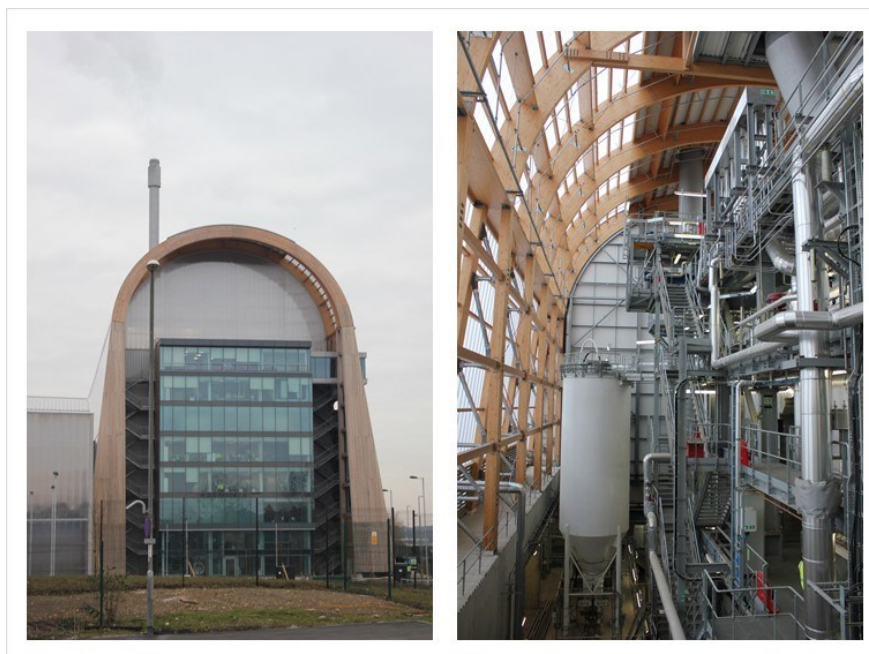
Abbildung 56: Glasfassade (links) und Holzkonstruktion (rechts) der Leeds RERF
