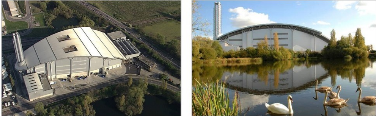
Abbildung 61: Aufsicht (l) und Seitenansicht der Lakeside EfW mit Blick über den Colnbrook West Lake (r)
