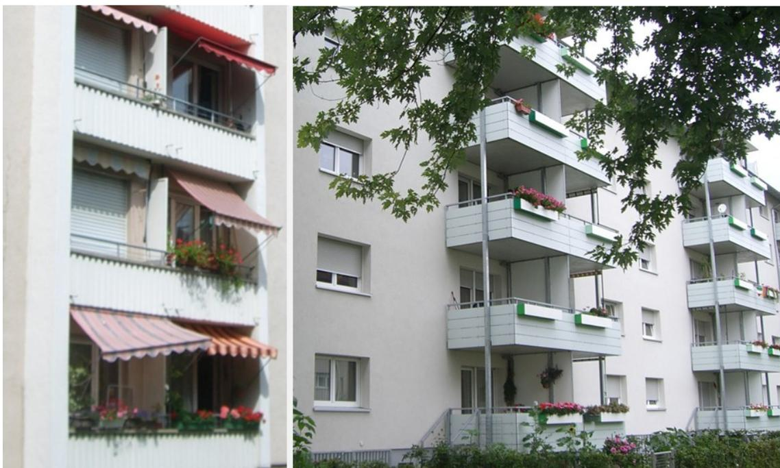
Abb. 3-5: Westfassade vor (links) und nach (rechts) der energetischen Modernisierung
