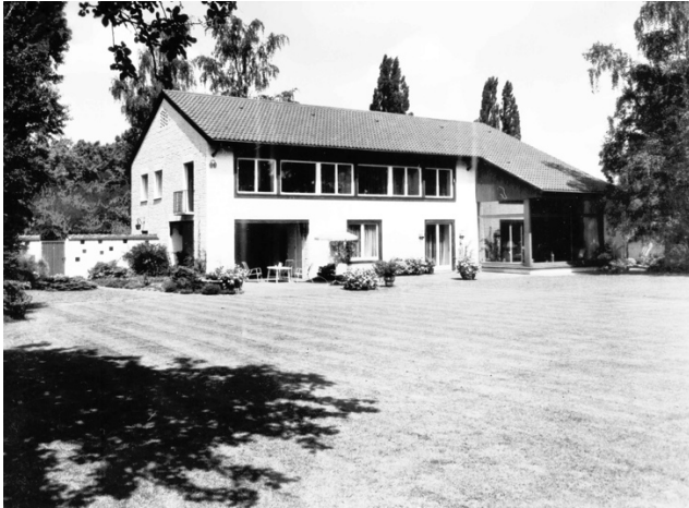
Haus Wittmer: Gartenseite mit Erkerzimmer unter dem abgeschleppten Dach (aus: Die Kunst und das schöne Heim , 59. Jg. 1961, Heft 6, S. 229)
