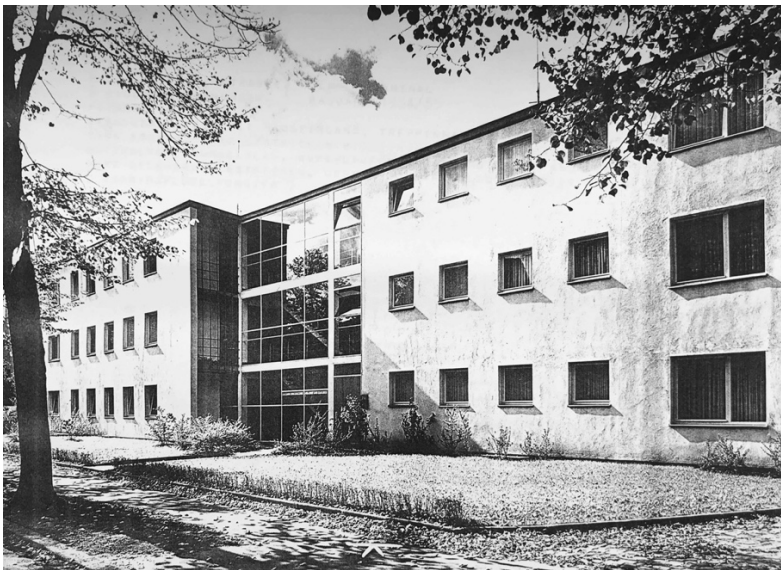
Mehrfamilienhaus an der Landgrafenstraße (aus: Baumeister , 56. Jg. 1959, Heft 6, S. 390)
