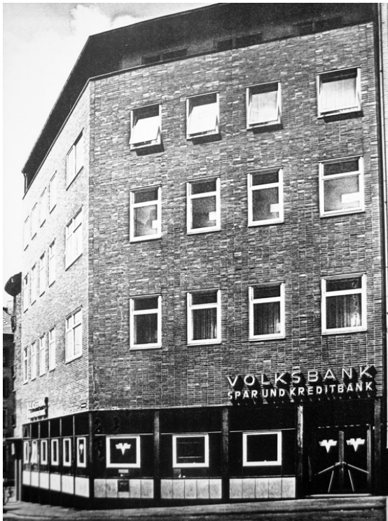
Volksbank Duisburg-Ruhrort: Umbau mit schlichter Fassadengestaltung (aus: Jürgen Brandt, Banken und Sparkassen , München 1960, S. 99)
