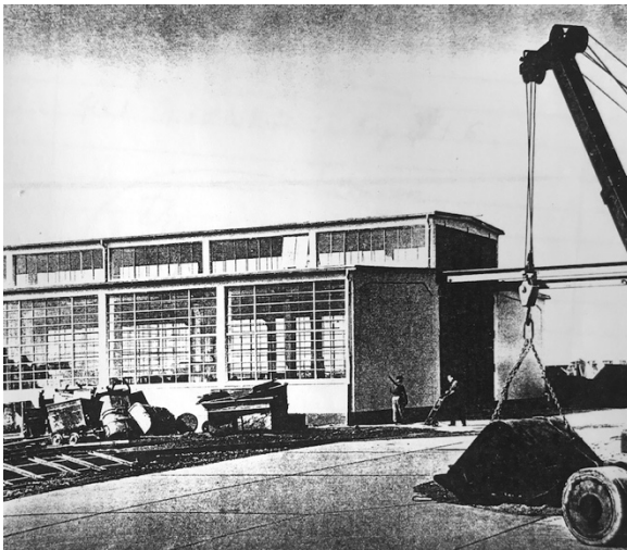
Werkstatthalle des Bauhofs der Hochtief AG (aus: 75 Jahre Hochtief Aktiengesellschaft für Hoch- und Tiefbauten vorm. Gebr. Helfmann (= Das Spezial-Archiv der Deutschen Wirtschaft), Mainz, o. J. (1951), o. S.)
