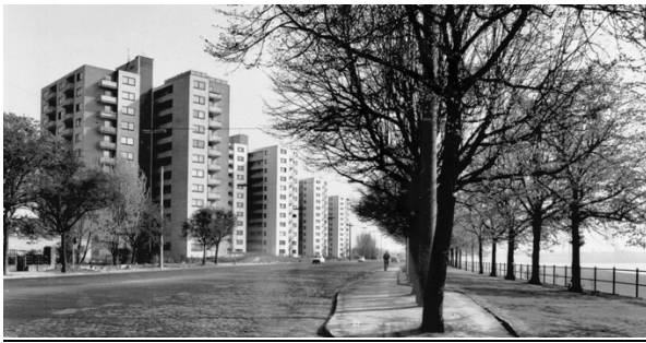
Die vier Punkthäuser der Siedlung am Niederländer Ufer (aus: Deutsche Bauzeitschrift , 1964, Heft 10, S. 133)
