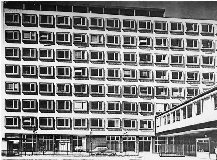
Ford-Bürohochhaus (Foto: Inge von der Ropp, Historisches Archiv der Stadt Köln, Bestand 1360, A 41, © Historisches Archiv der Stadt Köln)
