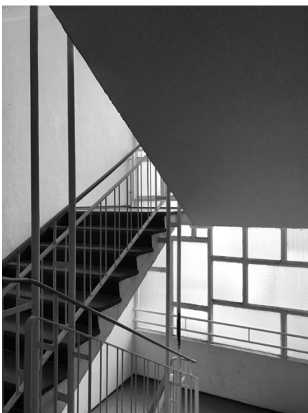
Treppenhaus des Punkthauses Rotterdamer Straße 4, 2020 (Foto und © Ute Reuschenberg) WV 98
