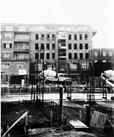
Baustelle des Hotels Brächter in Essen, 1960 (Foto: Privatarchiv Hans Petzold)
