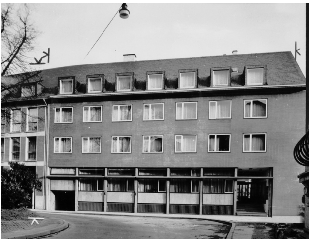
Zentralkasse Westdeutscher Volksbanken, Fassade am Gereonsdriesch (aus: Glasforum , 6. Jg. 1956, Heft 2, S. 19)
