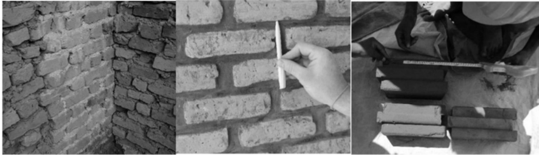
Abb. 1: Herkömmliche Ziegel, Abmessung der Steine, ISSB (Quelle: IoG e.V.)
