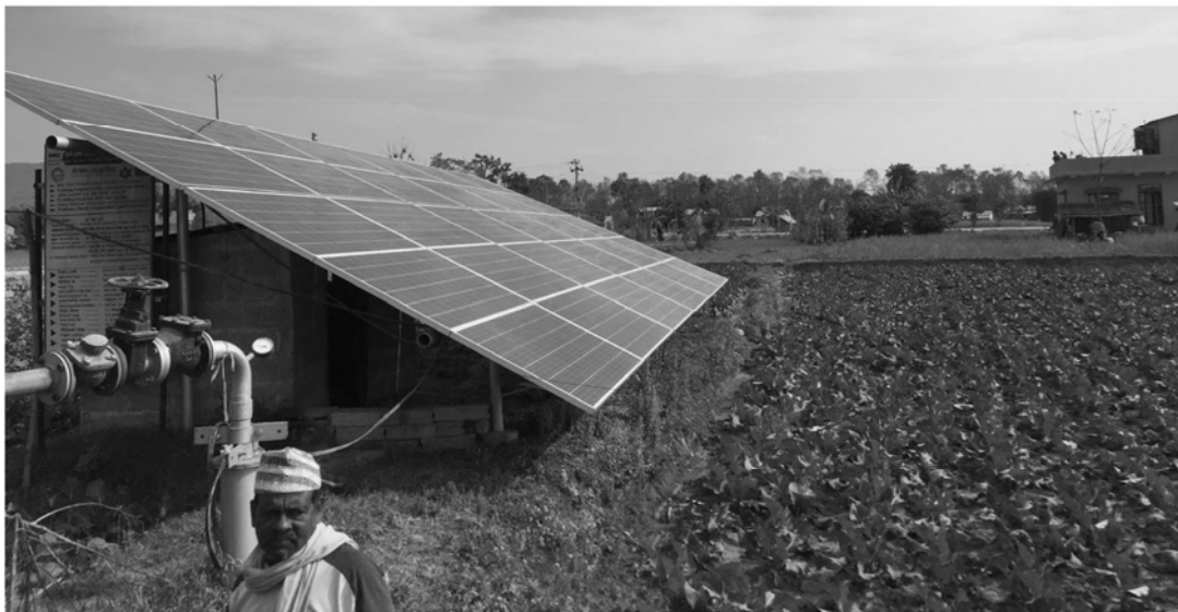
Abbildung 4: Solarbetriebene Wasserpumpe für Dorfgemeinschaften (Seitenansicht).
