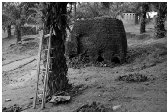
Abb. 3: Zisterne gebaut aus CSEB (Quelle: IoG e.V.)
