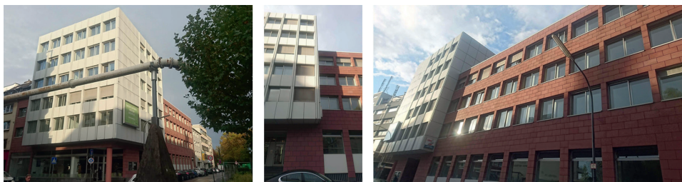
Bild 4 Straßenseitige Ansichten des Bürobestandsgebäudes an der Ecke Severinstraße und Löwengasse in Köln (© JP REB TU Dortmund)
